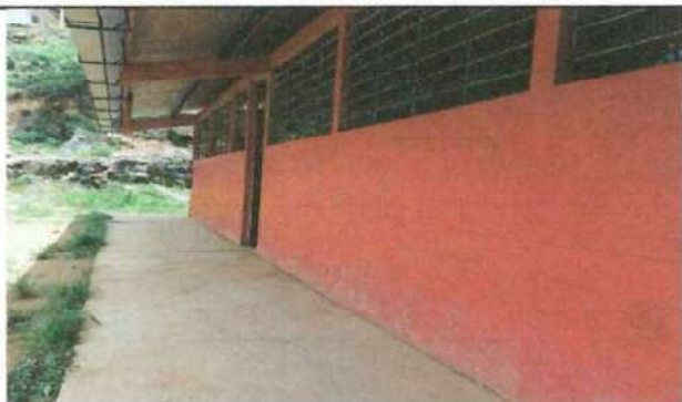
Foto 5: Paredes exteriores con necesidad de cambio de color de pintura.
