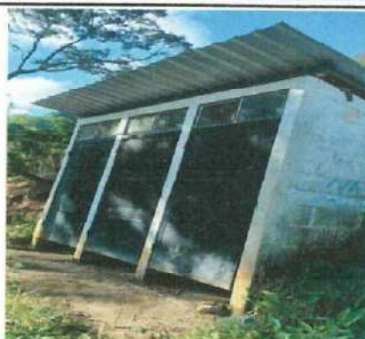
Foto 2: Pintura a puertas de baños y cambio de ducto de drenaje.
