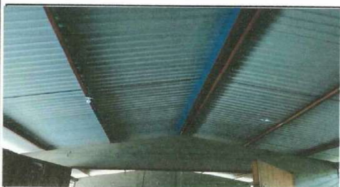
Foto 3: Mantenimiento y pintura a estructura de techos.
